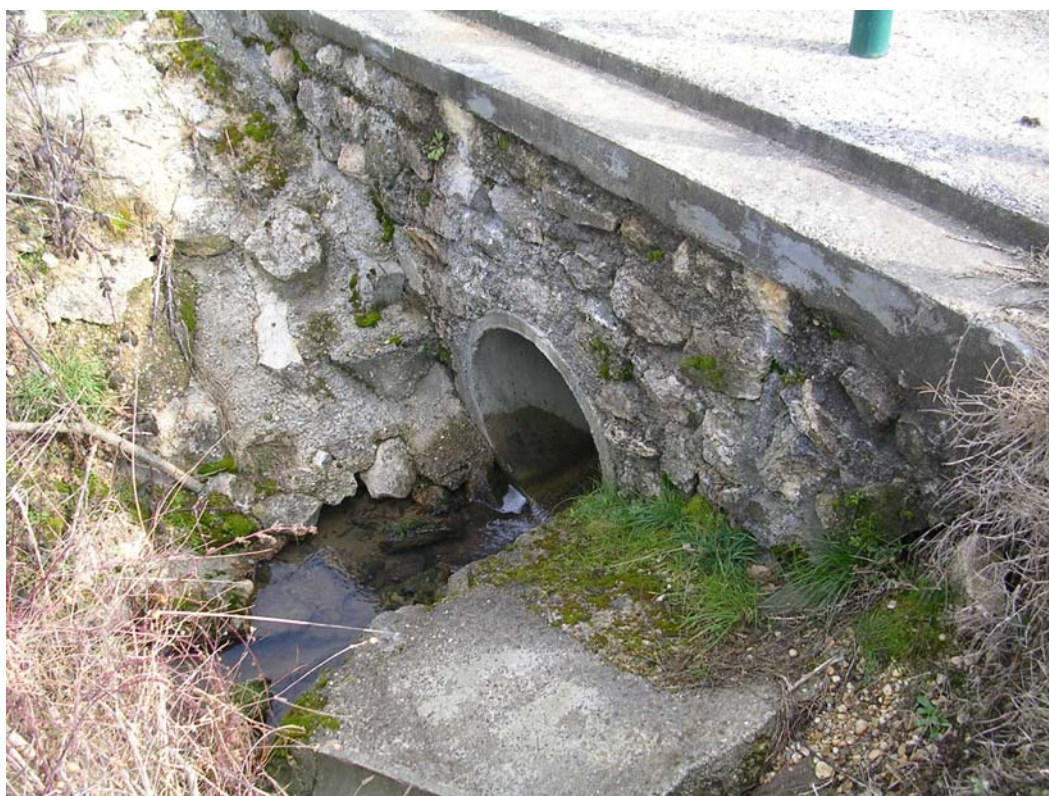
Vue de l'aval de l'ouvrage : dégradation de l'ancrage.
