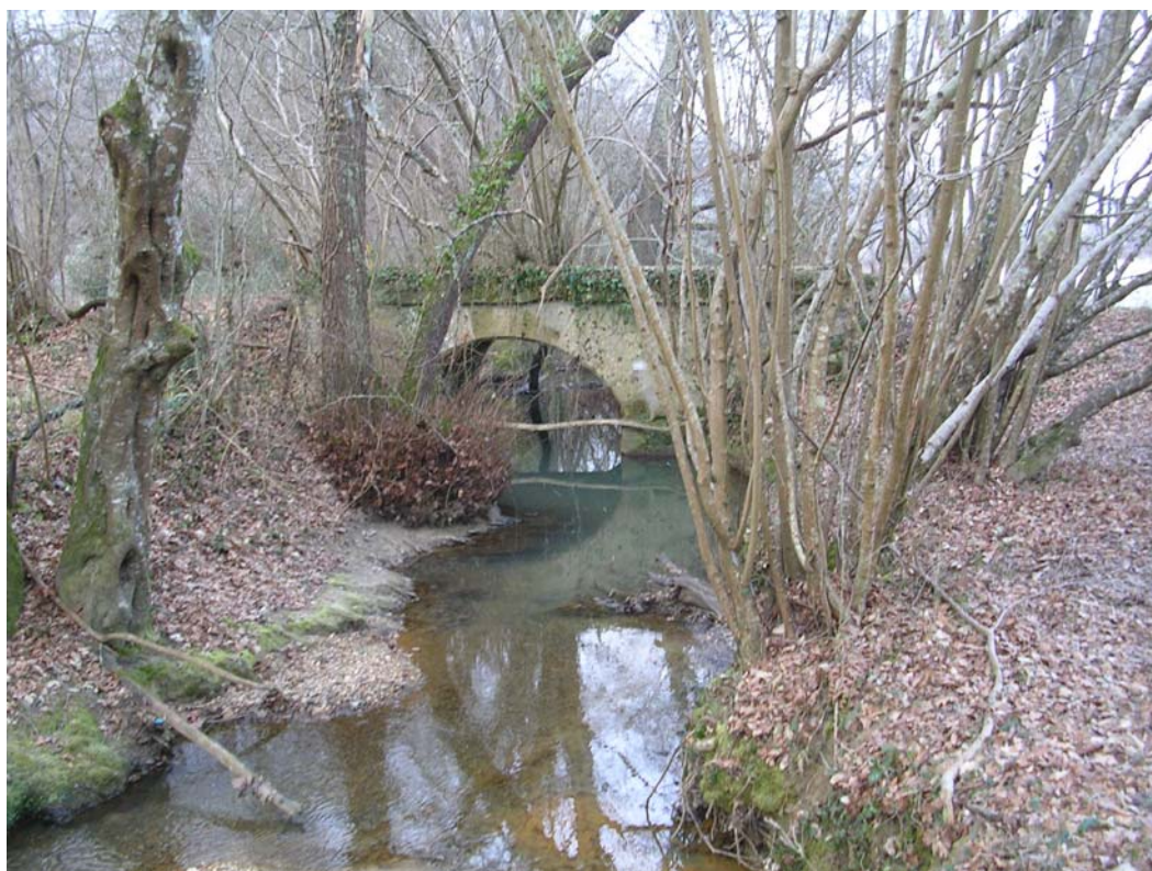
Ouvrage vu de l'amont. Dégradations locales de berges
