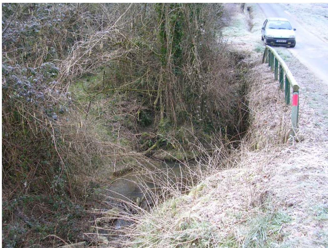
Ouvrage vu de l'amont : coude avant le franchissement et érosion de berge en rive gauche
