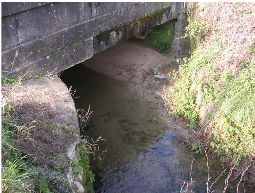
Amont de l'ouvrage : réduction de la section d'écoulement du lit mineur.
