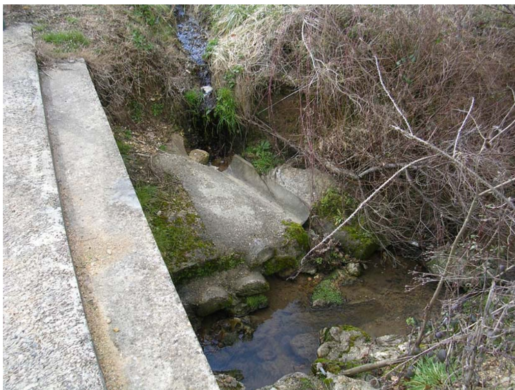
Dégradation de l'ancrage en aval de l'ouvrage. Connexion collecteur / lit mineur.
