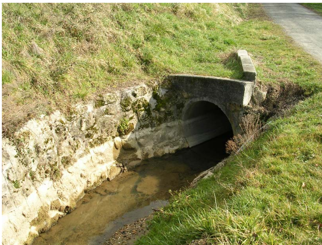
Ouvrage vu de l'aval : protection de berges en rive droite.
