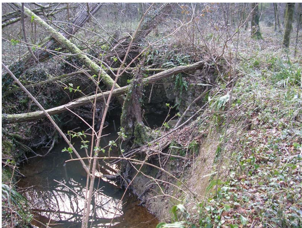
Ouvrage vu de l'amont : dégradation de l'ancrage rive droite et encombrement du lit.
